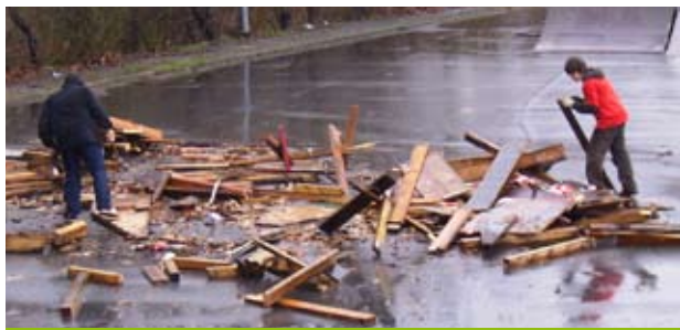
KAHLE FLÄCHE NACH DEM ABRISS
